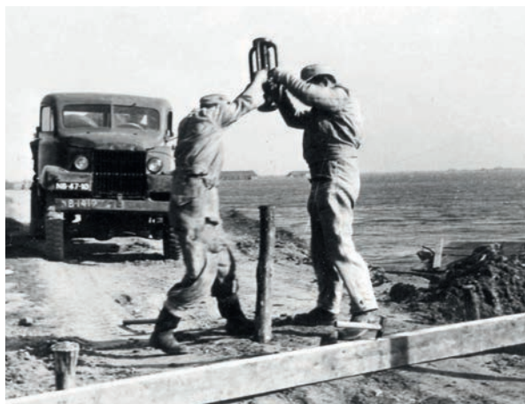
'Holland Einsatz', Duitse hulptroepen bezig met herstelwerkzaamheden in de buurt van Nieuwerkerk (foto: Zeeuws Archief, Beeldbank Schouwen-Duiveland)
