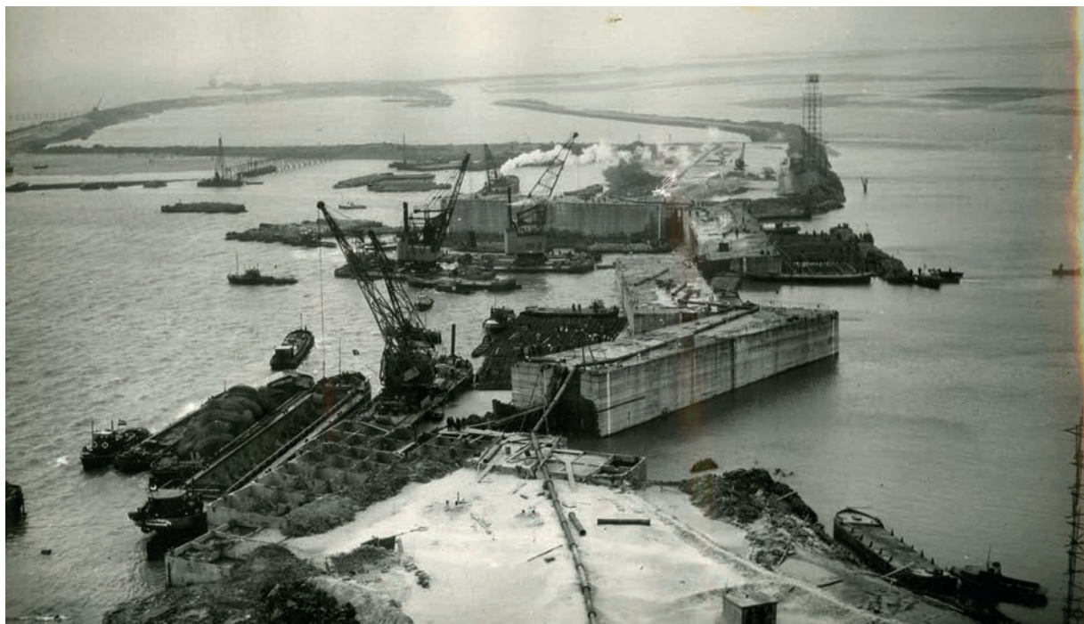
Sluiting van het laatste dijkgat te Ouwerkerk met behulp van Britse Phoenixcaissons uit de Tweede Wereldoorlog (foto: Zeeuws Archief, Beeldbank Schouwen-Duiveland)
