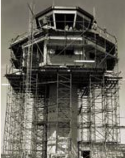
De verkeerstoren van het marine- vliegveld in aanbouw. Foto uit 1981.
